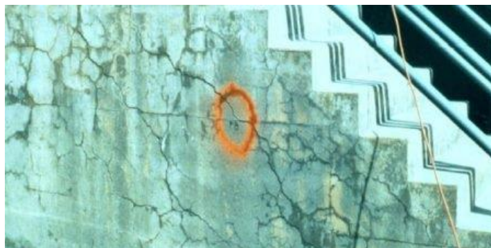
Рис.12: Растрескивание из-за щелочно-кремниевых реакций
