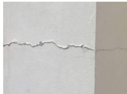
Рис.2: Растрескивание вследствие теплового движения
