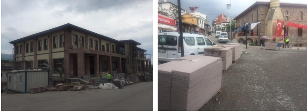
Şekil 6: a) Çok amaçlı bina inşaatı, b) Çarşı içi yol zeminleri ve kaldırımlar sökülerek yerine Arnavut taşı döşeme çalışmaları
