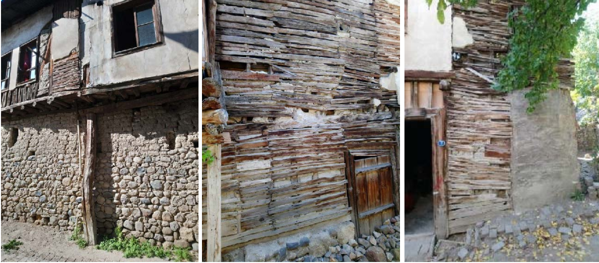
Görsel 36. Yapının zemin katında yer alan ahşap ve taş malzemenin kullanıldığı bölümler
