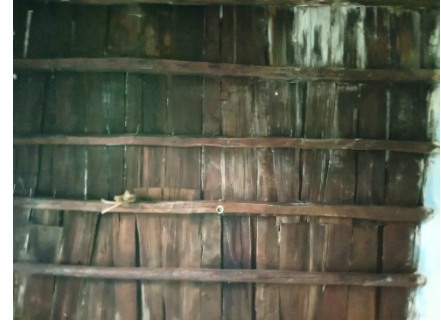
Görsel 35. 105 no.lu mutfak ahşap kirişleme tavan, 2022
