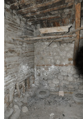
Görsel 13. Zemin ahır (Z03) ahşap kirişleme tavan, 2022
