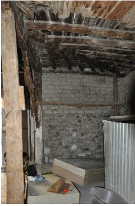
Görsel 11. Zemin kat ana giriş (Z01) ahşap kirişleme tavan, 2022
