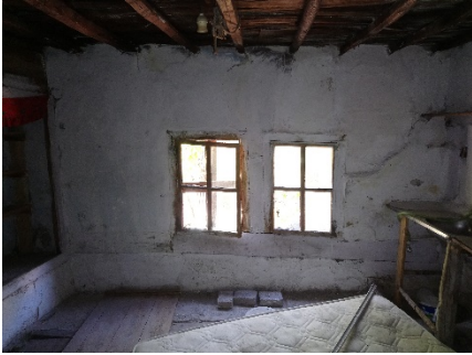
Görsel 33. 105 no.lu mutfak pencereler, ahşap döşeme, 2022
