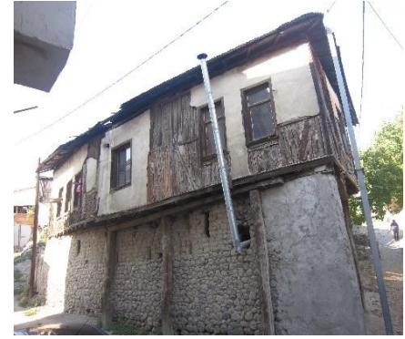
Görsel 39. Güneydoğu cephesi, 2022
