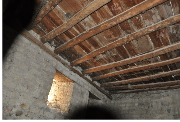
Görsel 12. Zemin kat samanlık (Z02) ahşap kirişleme tavan, 2022
