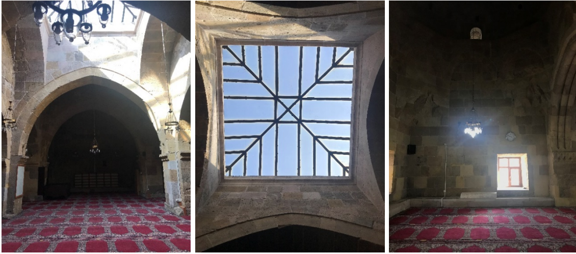
Şekil 3. Niğde Alaaddin Cami tepe penceresi ile doğal aydınlatmasının sağlanması 2021.
