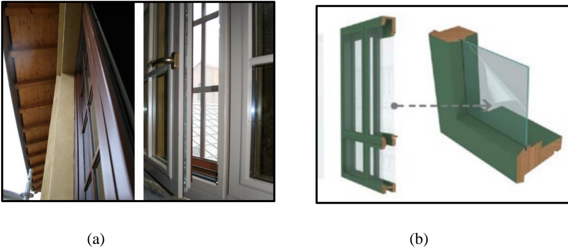
Resim 2. İkincil pencere uygulaması (a) (Url 6), Low-e film uygulaması ile camın performansının artırılması(b) (Url 1)
