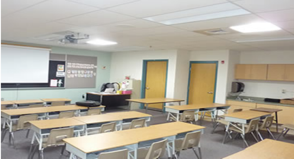
Şekil 3. Doğrudan aydınlatma yapılan bir derslik
