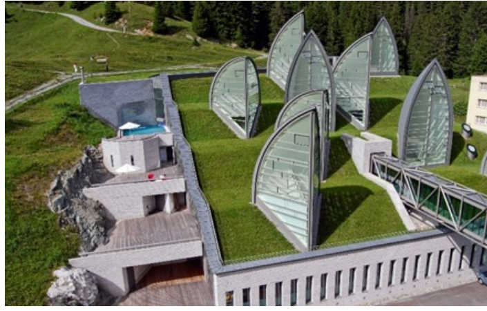
Şekil 6. Tschuggen Bergoase Otel (Kaynak: https://zinco-greenroof.com/references/tschuggen )
